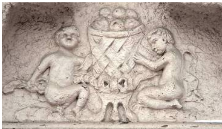
Ēka Krāsotāju ielā Nr. 11, celta 1912. gadā, arhitekts Roberts Donbergs. Ieejas mezgla portāla fragments. 2011. gads.
