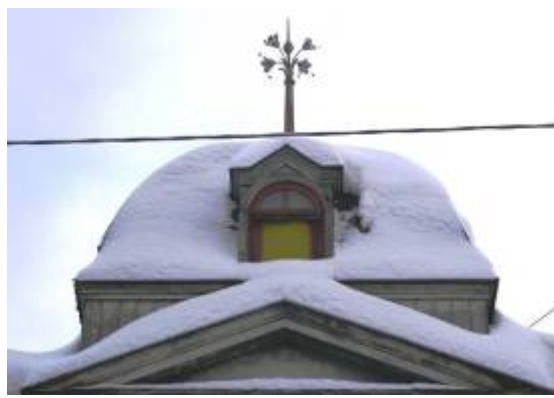
Ēka Krāsotāju ielā Nr. 6, celta 1898. gadā, arhitekts Alfrēds Pilemans. Frontons. 2011. gads.
