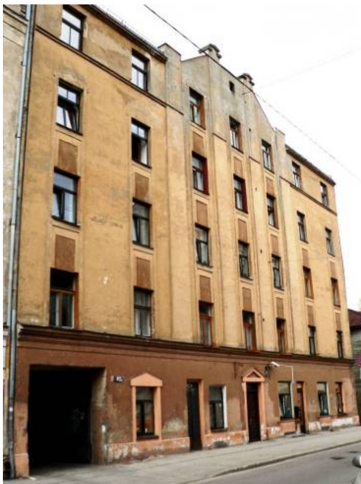
Ēka Krāsotāju ielā Nr. 27, celta 1912. gadā, arhitekts Eižens Pole. 2011. gads.
