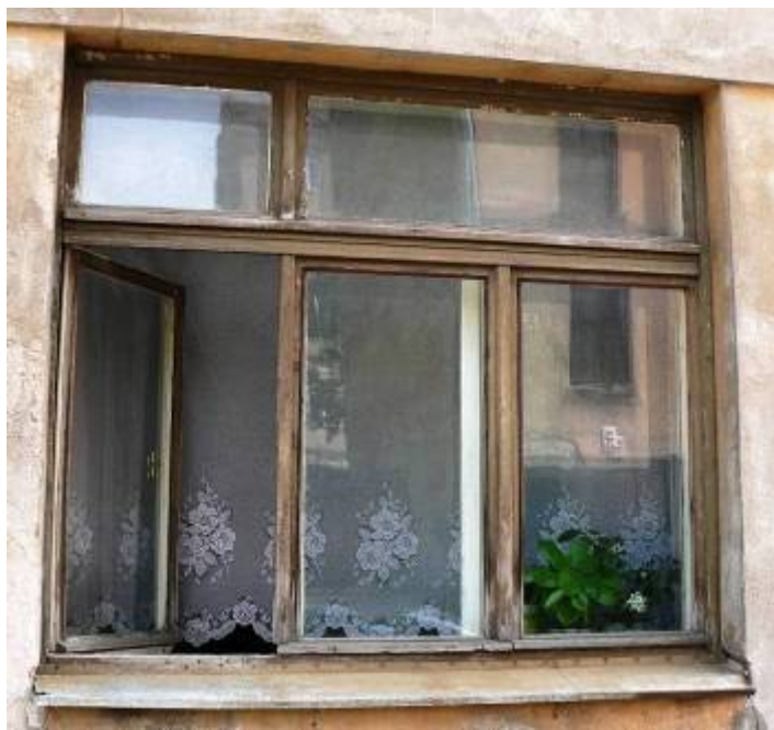
Ēka Krāsotāju ielā Nr. 14, celta 1934. gadā, arhitekts Artūra Braunfelds. Logu ailes rūtojums piemērots divdaļīgiem logu rāmjiem. 2011. gads.
