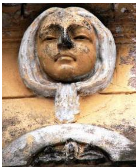
Ēka Krāsotāju ielā Nr. 18, celta 1902. gadā, tehniķis Indriķis Devendruss. Gorgona. 2011. gads.
