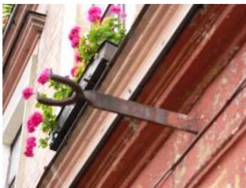
Ēka Krāsotāju ielā Nr. 22, celta 1896. gadā, arhitekts Kārlis Felsko. Tirdzniecības reklāmas metāla kronšteins.2012. gads.
