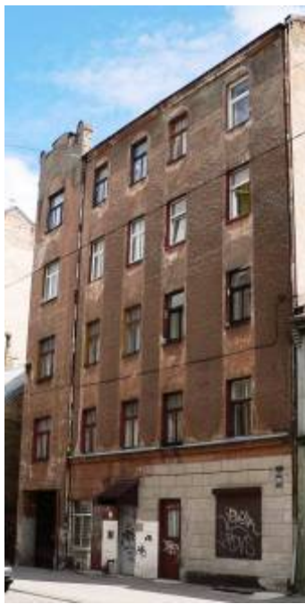
Ēka Krāsotāju ielā Nr. 28, celta 1910. gadā, tehniķis Indriķis Devendruss. 2011. gads.
