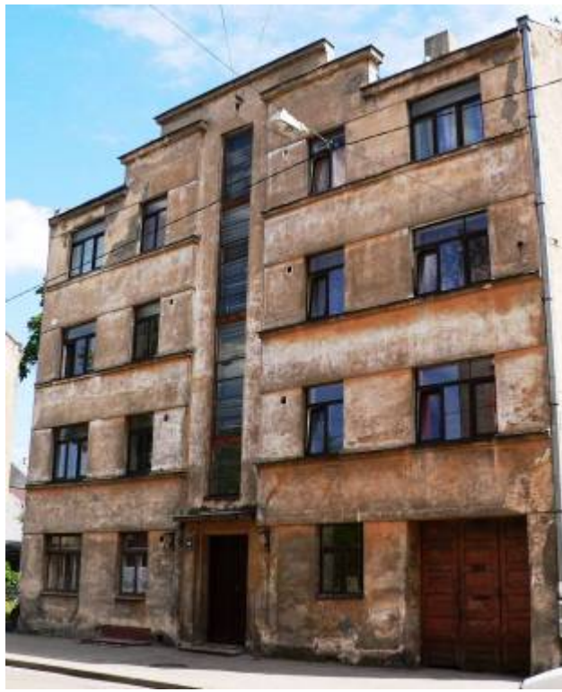
Ēka Krāsotāju ielā Nr. 14, celta 1934. gadā, arhitekts Artūra Braunfelds. 2011. gads.
