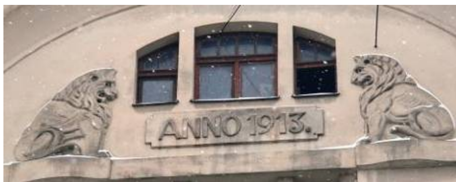
Ēka Krāsotāju ielā Nr. 32, celta 1913. gadā arhitekts Jānis Alksnis, Tallinas ielas frontons. 2011. gads.
