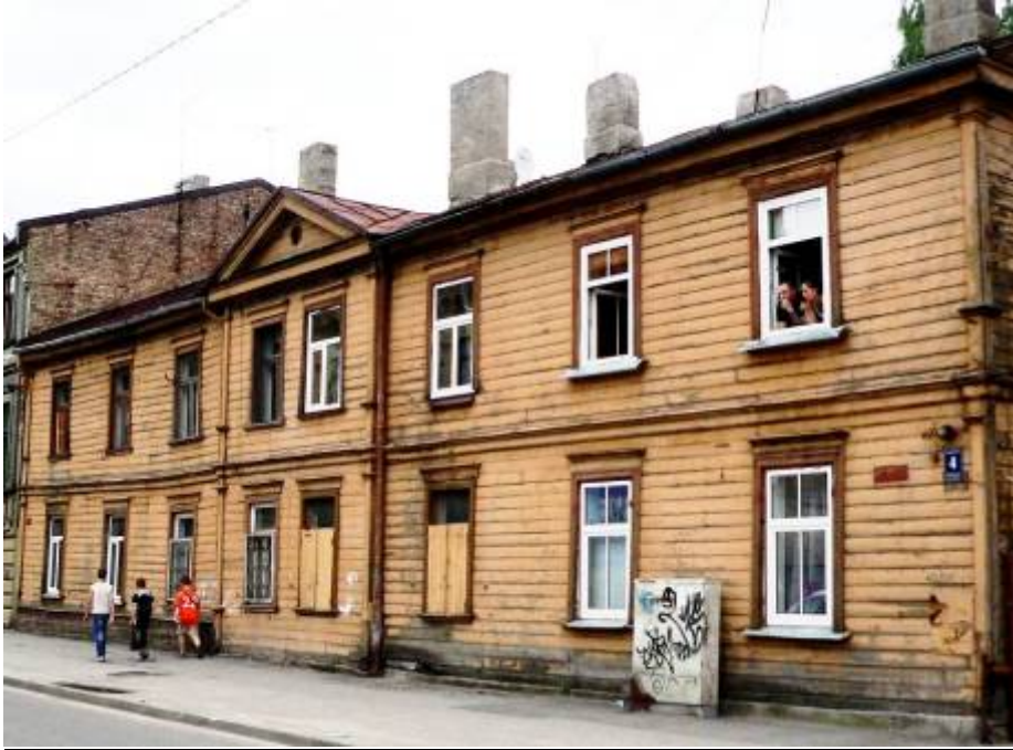
Ēka Krāsotāju ielā Nr. 4, celta 1895. gadā, arhitekts Konstantīns Pēkšēns. 2011. gads.
