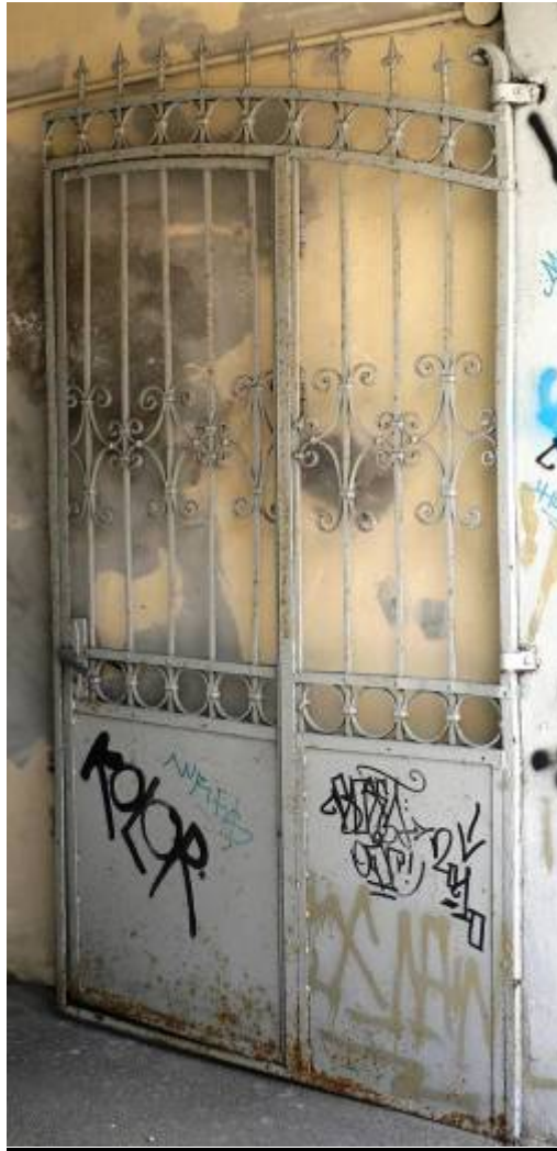
Ēka Krāsotāju ielā Nr. 18, celta 1902. gadā, tehniķis Indriķis Devendruss. Caurbrauktuves metāla kaltie vārti. 2011. gads.
