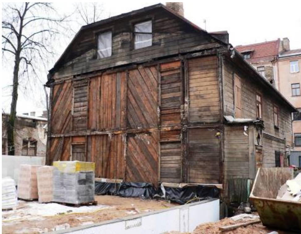
Krāsotāju ielā Nr. 12.Pamati. 2011. gads.
