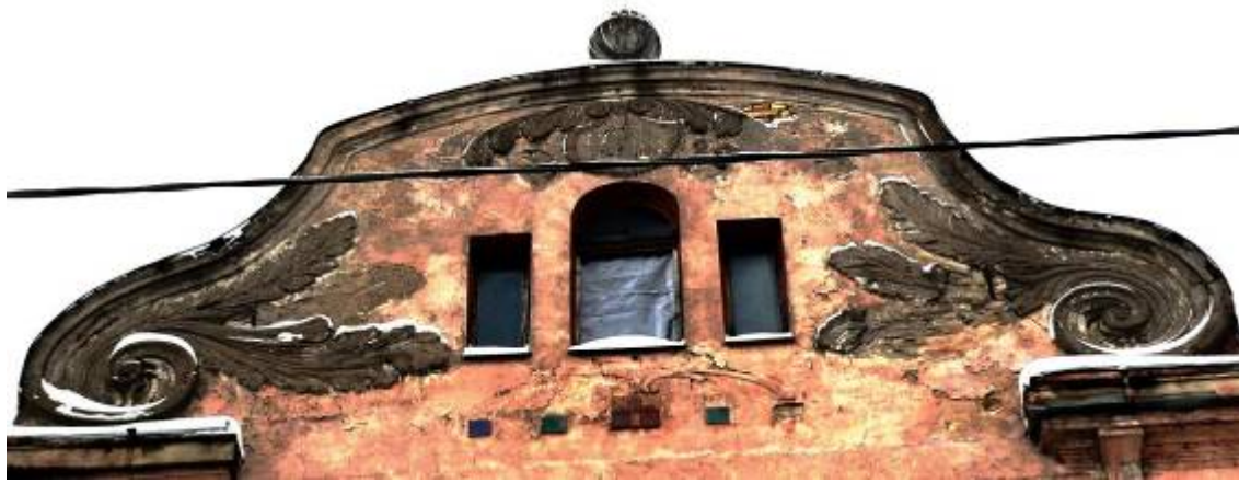
Ēka Krāsotāju ielā Nr. 11, celta 1912. gadā, arhitekts Roberts Donbergs. Frontons. 2011. gads.
