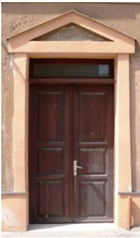
Ēka Krāsotāju ielā Nr. 27, celta 1912. gadā, arhitekts Eižens Pole. Ieejas durvju ailes portāls. 2011. gads.
