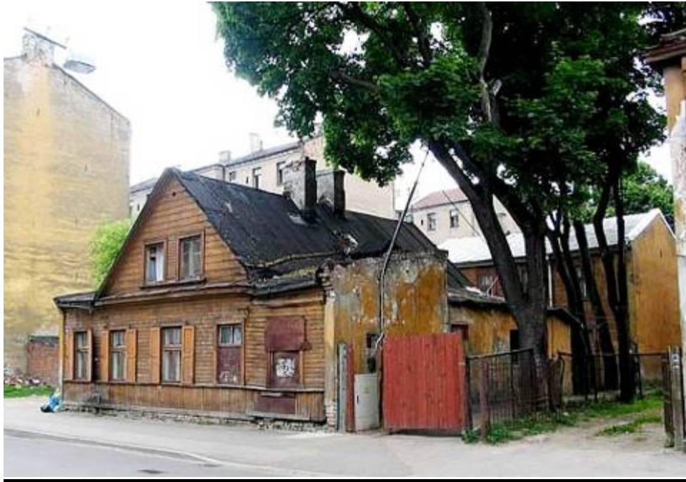
Krāsotāju ielas vecākas ēkas Nr. 15 atliekas, celta 1873. gadā, arhitekts H. Geigenmīllers. 2009. gads. Ēka izdegusi 2010. gadā.
