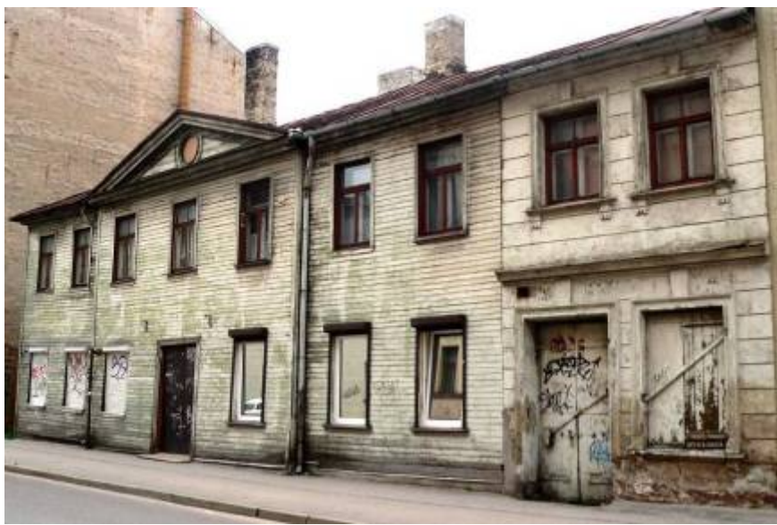
Ēka Krāsotāju ielā Nr. 29, celta 1894. gadā arhitekts Apoloniuss Edelsons 2011. gads.
